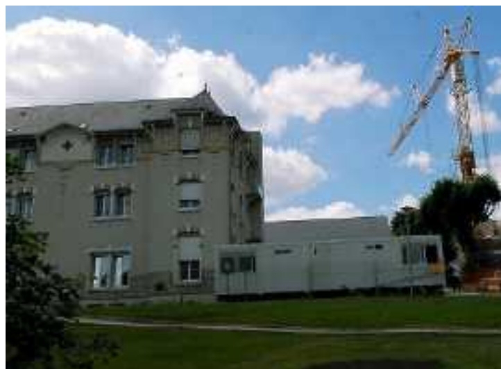
Dans l'ancien sanatorium reconverti il y a 40 ans en centre de rééducation, des travaux de rénovation s'imposaient.
