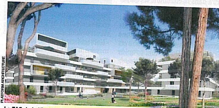
La ZAC de la Victoire (400 logements et du tertiaire dans les pinèdes), un projet phare conçu par Platform Architecture, mandataire, associé à Reichen & Robert.
