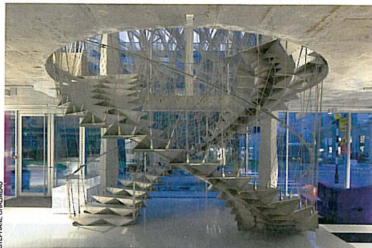
Le bâtiment Manny conçu par Michel Bertreux a été inauguré début décembre. Ci-dessus, le spectaculaire escalier suspendu en acier du rez-de-chaussée.
